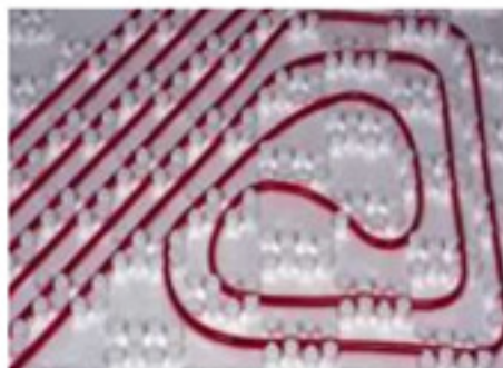
Foto: Sistem površinskog grejanja
